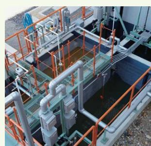
排水処理設備を増強。ガスクーラー冷却水を循環使用し、工場全体の水使用量も抑制しています。
