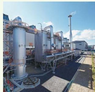
最新式の電気集塵機を採用し、細かな塵まで静電気の力で確実に捕集。地域環境に配慮しています。
