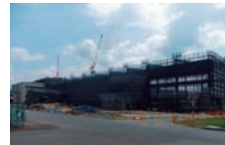
増設工事中新工場（一部）
